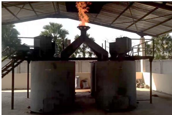
Plateforme de carbonisation du CITA
